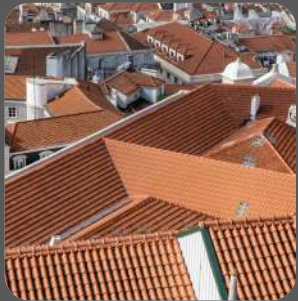
Toiture en tuile
